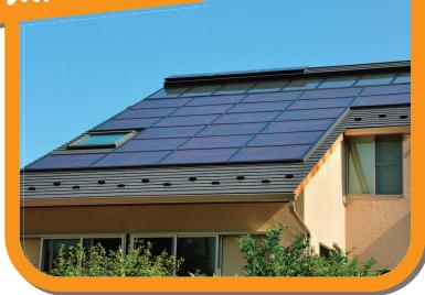
太陽光発電システムは、半導体を利用して、光のエネルギーを電気に変えることができるシステムです。住宅の屋根でも十分に発電ができ、日中に使いきれない電気は、余剰電力として販売できます。蓄電池を設置すれば、発電した電気を夜間や停電時でも使用できるので安心です。
