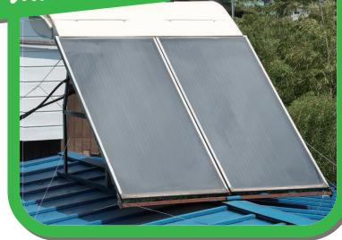
太陽の熱を暖房や給湯に利用する太陽熱利用システムには、小さな屋根面積でも十分にお湯をつくれるものや、太陽熱で家全体を温めるものなどがあります。家庭で使うエネルギーの半分以上が暖房や給湯の熱エネルギーです。熱をそのまま熱として使う太陽熱利用システムは、太陽の光が持つエネルギーの約40%を活用できるのでとても効率的です。
